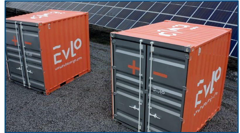
カナダ、モントリオール近郊の太陽光発電施設に接続されている 4 MWh のエネルギー貯蔵システムに組み込まれた 2 台の EVLO 500。(画像著作権: EVLO Energy Storage Inc., 2021)
