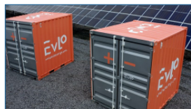
カナダ、モントリオール近郊の太陽光発電施設に接続されている 4 MWh のエネルギー貯蔵システムに組み込まれた 2 台の EVLO 500。 (画像著作権: EVLO Energy Storage Inc., 2021)
